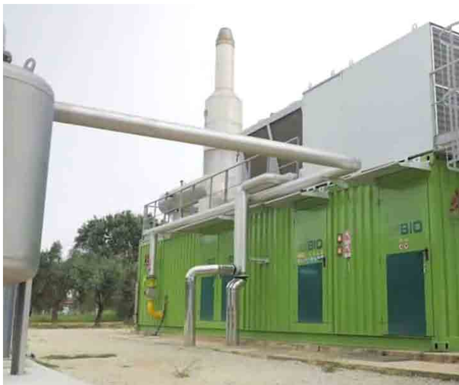
L'impianto di trigenerazione Ecomax® 10 BIO, installato da AB
