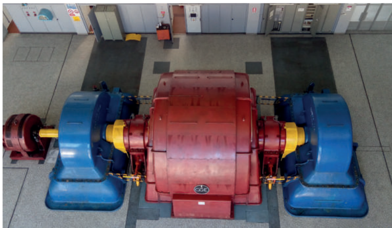
Turbina Pelton con portata nominale 4m 3 /s, salto motore nominale 966m e potenza meccanica 35375kW
