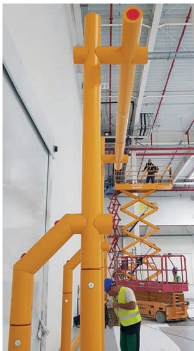
La protezione perimetrale per porta e il limitatore d'altezza STOMMPY sono dotati di resistenza agli impatti fino a 21.000 joule alla base del montante e fino a 5300 joule in mezzzeria della traversa superiore, resistenza ai raggi UV in conformità al DIN-EN-ISO 877 7-8 della Scala Blu e comportamento alla fiamma HB UL 94
