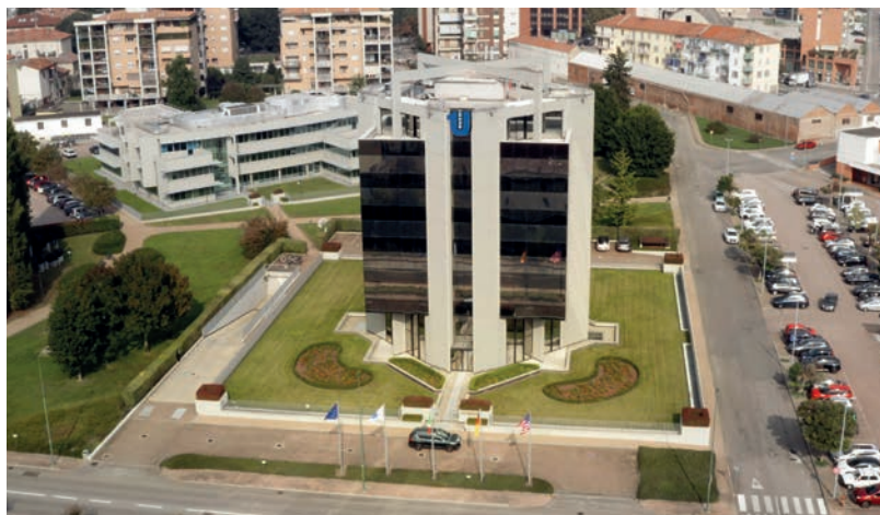
Headquarter di Casale Monferrato (al)
