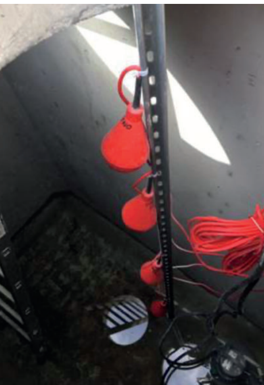
Figura 2. Livelli di comando azionamento pompe di rilancio
