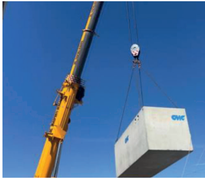
Figura 1. Vasca di laminazione prefabbricata durante le fasi di posa
