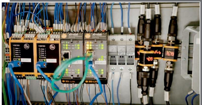
Centraline diagnostiche per sensori di vibrazioni, Master IO-Link CabinetLine e display LED per la conversione del segnale di valori letti analogici con IO-Link
