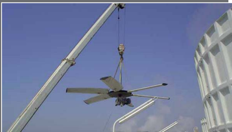
Figura 2 – Installazione di un ventilatore con riduttore in una centrale elettrica
