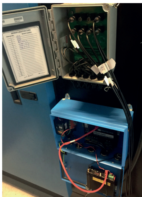
La JB già installata per collegare lo strumento portatile PRUFTECHNIK VIBXPERT® II, e acquisire i dati in modalità ronda
