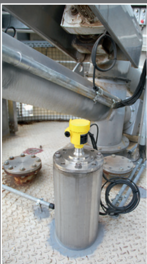
Il VEGAPULS 69 è stato installato sul tronchetto preesistente per ragioni pratiche. Di per sé non è necessario un tronchetto
