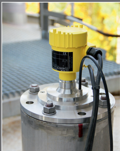
Il VEGAPULS 69 è stato installato sul tronchetto preesistente per ragioni pratiche. Di per sé non è necessario un tronchetto
