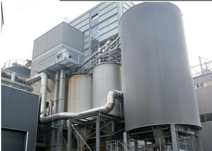
Nell'impianto di depurazione di Steinhäule, ogni giorno vengono sfruttate termicamente tra le 20 e le 40 tonnellate di fanghi essiccati
