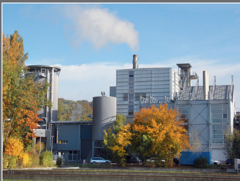
Nell'impianto di depurazione di Steinhäule, ogni giorno vengono sfruttate termicamente tra le 20 e le 40 tonnellate di fanghi essiccati
