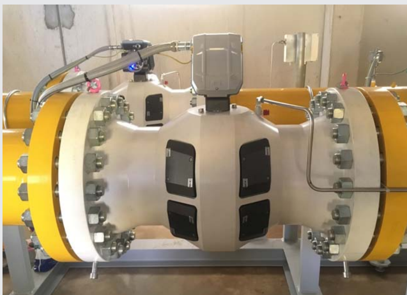
Flowsic600XT versione FORTE installati nella cabina di interconnessione di SGI Castel di Ieri (foto sopra e sotto)
