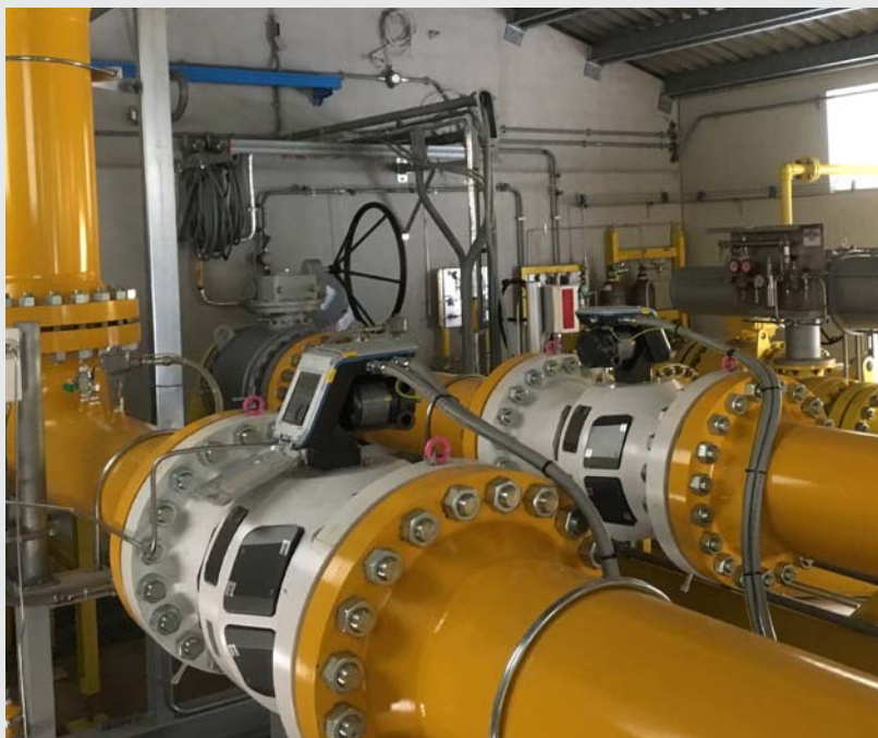
Flowsic600XT versione FORTE installati nella cabina di interconnessione di SGI Castel di Ieri (foto sopra e sotto)
