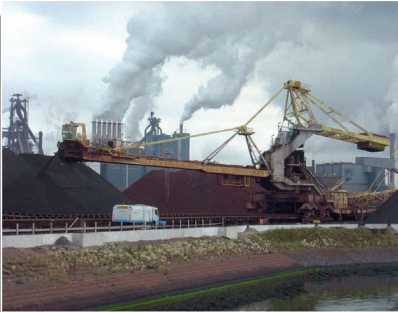
Caso 5 – La pala scavatrice condizionata da presenza di ruggine e usura dei componenti
