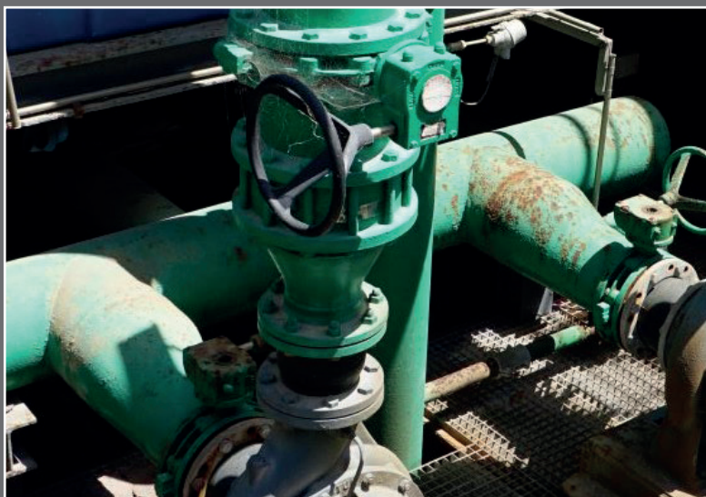
L'elemento della tubazione flessibile riduce deformazioni e tensioni della pompa
