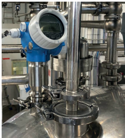
Misuratore di livello radar Micropilot FMR62 applicato su serbatoio
