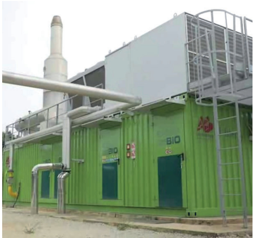
L'impianto di trigenerazione Ecomax® 10 BIO, installato da AB
