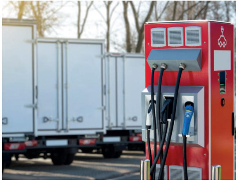
Un elemento particolarmente delicato, considerate le esperienze già in atto, è costituito dai plug per la ricarica, sovente soggetti a urti che ne comportano, se non il malfunzionamento, la compromissione del grado di protezione IP, con possibile introduzione di rischio elettrico per gli operatori.
