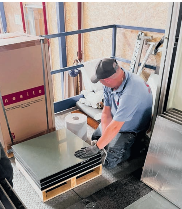
Fig. 2 Operazione di selezione e reimballaggio dei pannelli recuperati dal sito di dismissione.
